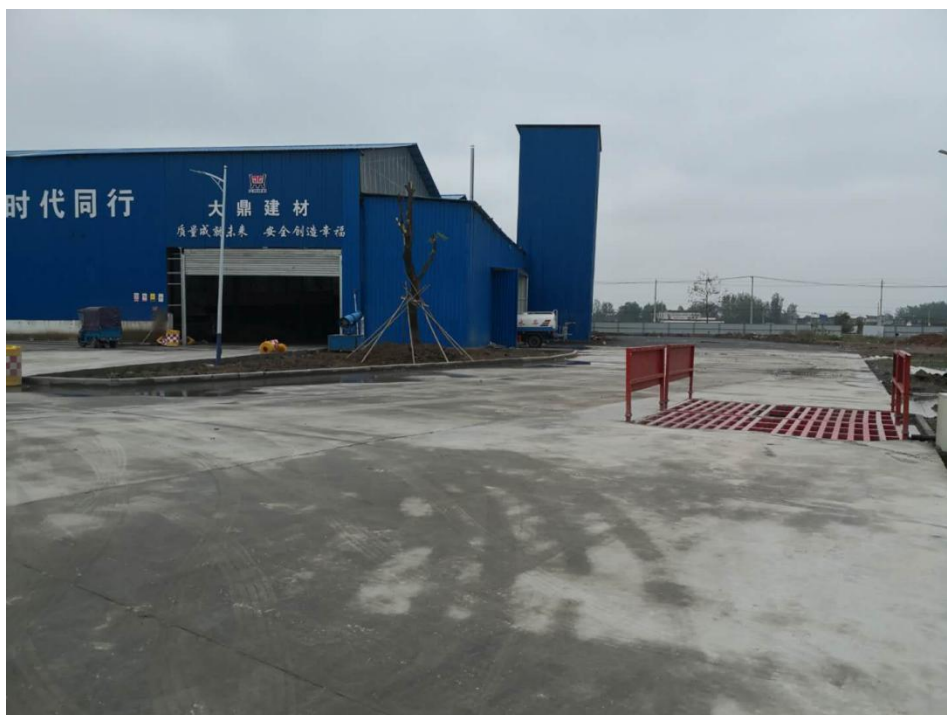
封闭式搅拌楼
