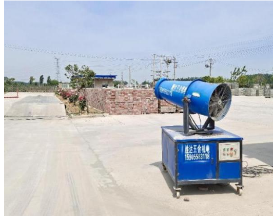
厂区雾炮抑尘设施
