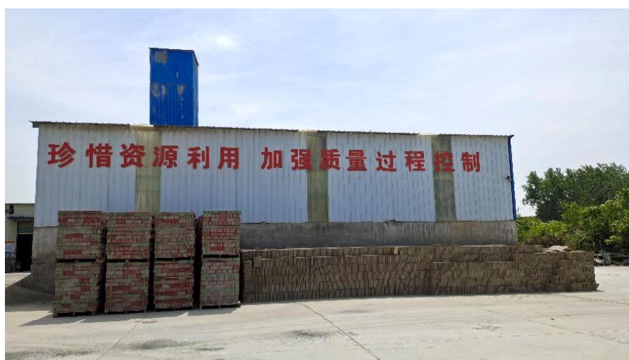
封闭式车间及封闭筒仓
