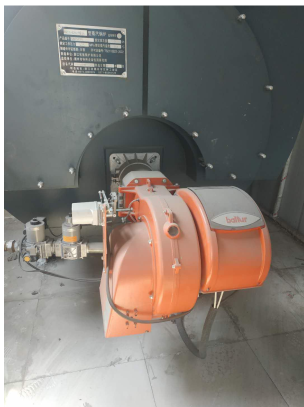
图 4.1-2 低氮燃烧装置
