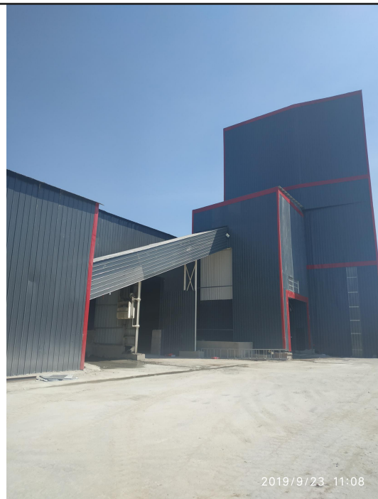
封闭料库、传输带及搅拌楼
